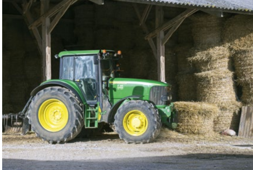
Abb.: Abstand von 2 m zu leicht entzündlichen Materialien wurde hier nicht eingehalten.
